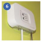
Затяните винты снизу на корпусе приемника.
